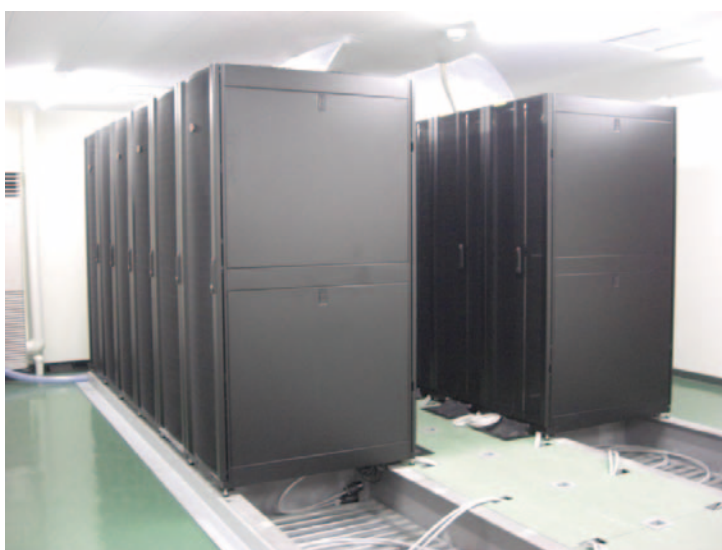
写真10.4.-4 新サーバ室への移設完了後のサーバ室
