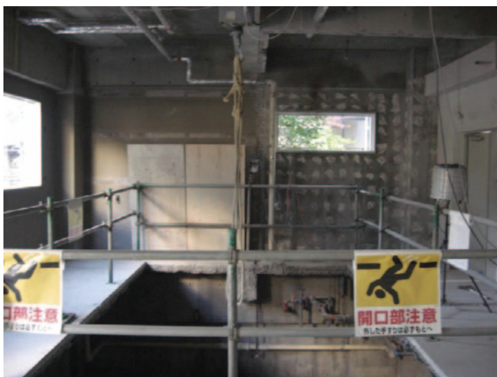
写真10.4.-1 工事途中の様子。鉄骨の構造物を入れるため、床が抜けている。壁も構造物を通すため空けられた状態（2014/12/15日撮影）
