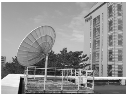
写真 2 FY2 受信用アンテナ。GMS5 受信用アンテナを撤去し、土台を流用した。
