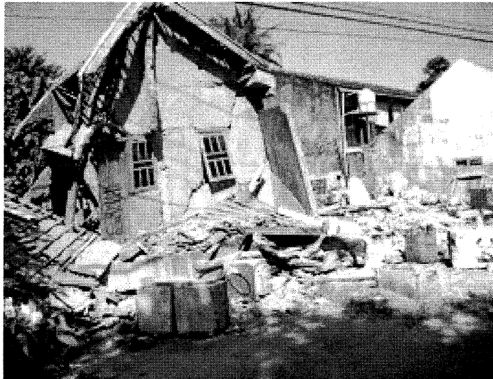
2006年6月8日に撮影した中部ジャワ地震被害建物
