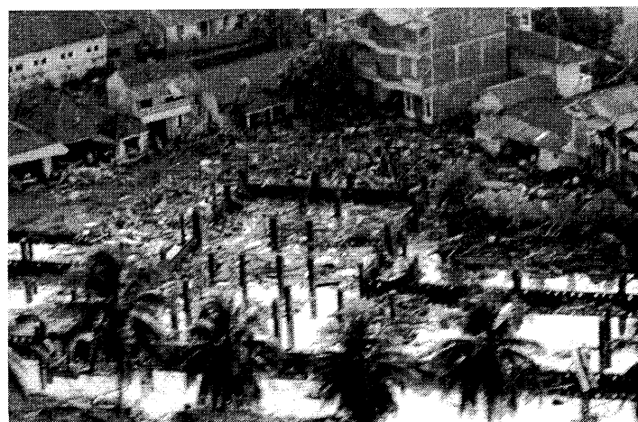
2006年7月18日に空撮した津波に襲われたパンアンダラン沿岸 (インドネシア国軍空軍Fokker A-2704内サイドカメラから)
