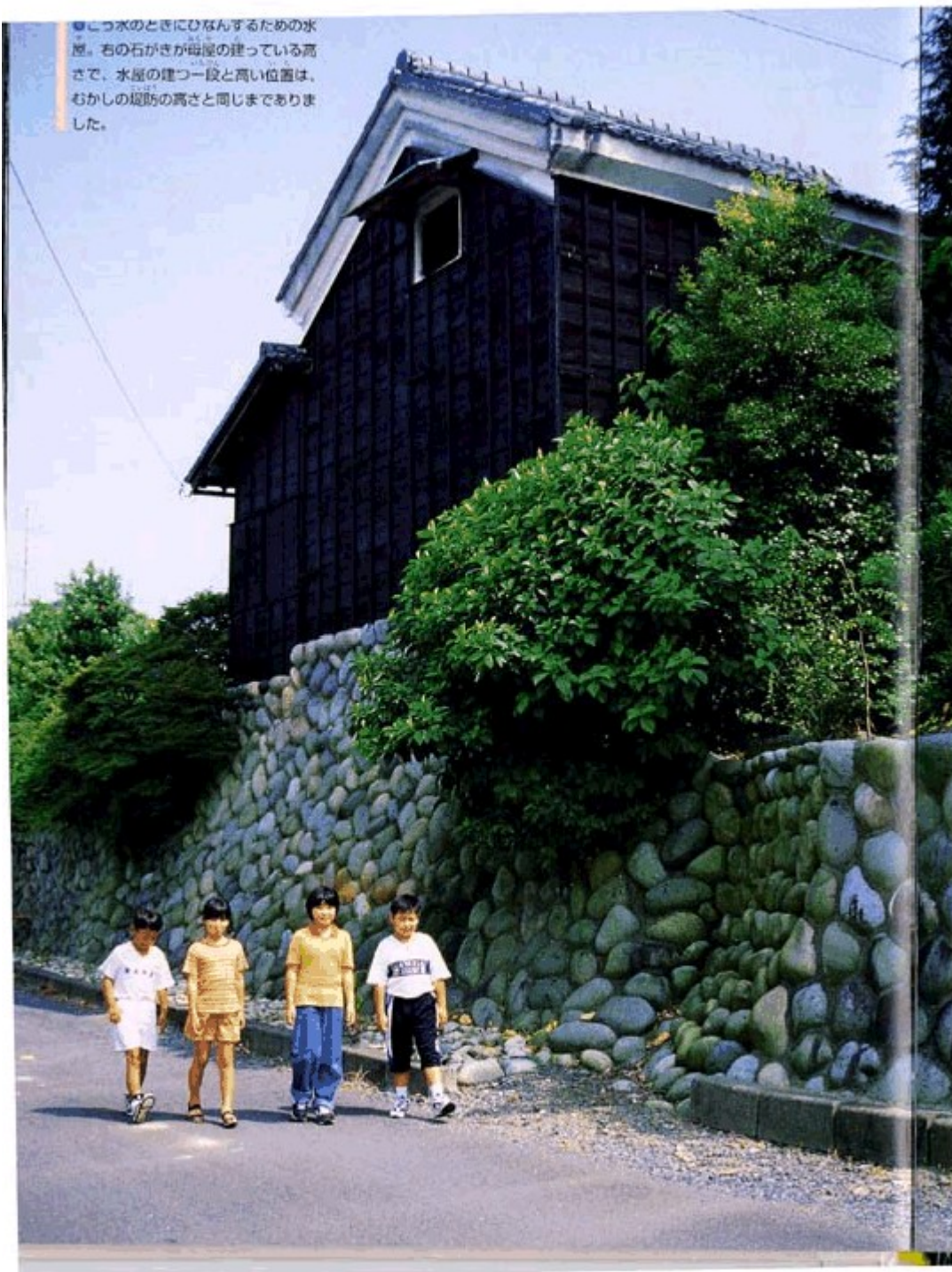
①家の建築現場。新しく家を建てるまえに、むかしからの家づくりのやりかたを守って、石がきと土盛りで土台を高く作っています。
