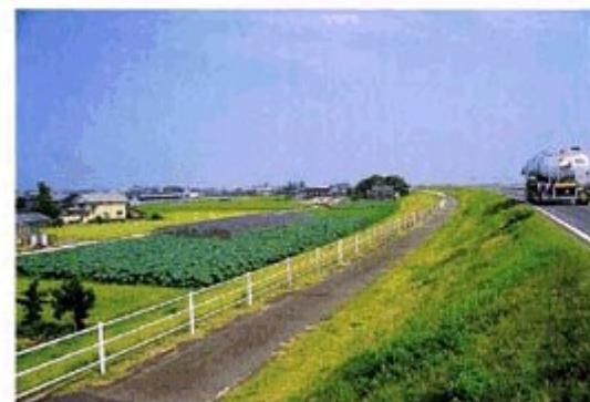
②明治20年から45年にかけて作られた堤防は改修を重ねて、むかしとはくらべものにならないほど、じょうぶなものになっています。堤防の上は、大型車が走りかう道路になっています。
