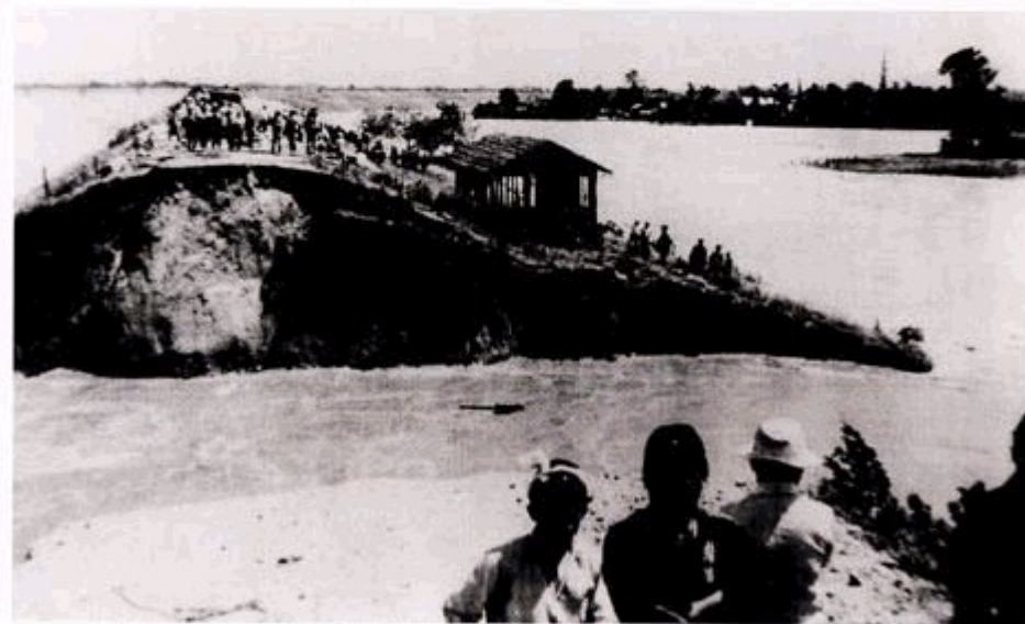
昭和27年6月24日、長良川右岸の海津郡平田町勝呂の堤防が切れました。ダイナ台風による集中豪雨のすさまじい破壊力のつめあです。2108戸が浸水しました。
