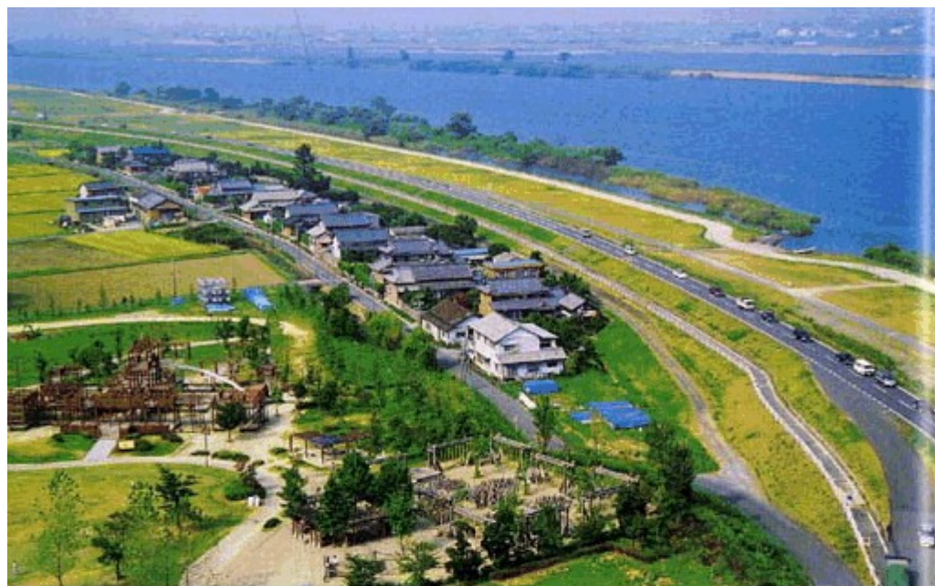
①上から木曾川、長良川と二つの川を分ける堤防が見えます。むかしは、この少し下流で二つの川と西がわを流れる揖斐川も合流したため、こう水がたびたびおきました。明治時代になって、オランダ人のデレーケの指導で三つの川に分けるといふむずかしい工事が成功し、こう水がへりました。
