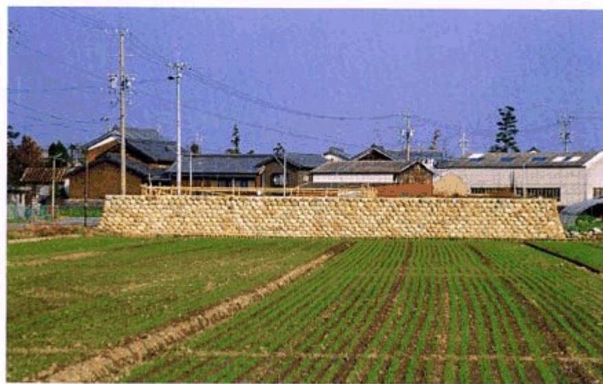
①家の建築現場。新しく家を建てるまえに、むかしからの家づくりのやりかたを守って、石がきと土盛りで土台を高く作っています。
