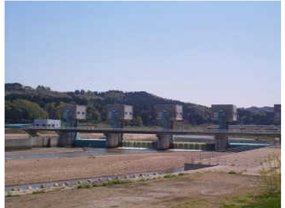
(信濃川左支川渋海川頭首工)
