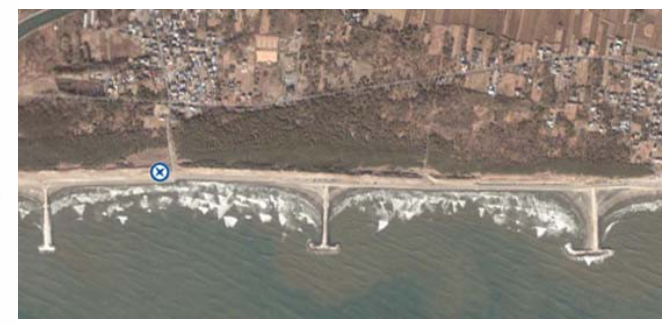
ヘッドランド(人工岬): 岬の間に砂がつくことになっている。ここではヘッドランドは機能していない(九十九里浜、吉崎浜)
