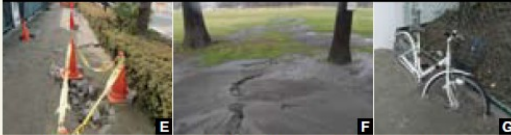
E 新木場の歩道でもブロックが持ち上がる F 噴砂丘には直径 2.5mのものもあった G 車輪の半分が埋まる自転車。堆積厚は30cm前後か。
