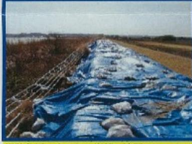
堤防亀裂、すべり、崩落、沈下 L≒400m
