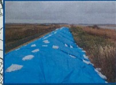
堤防亀裂 L≒100m H≒1~2m
