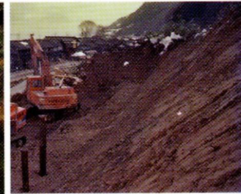
地すべり移動体の 末端部での切土
