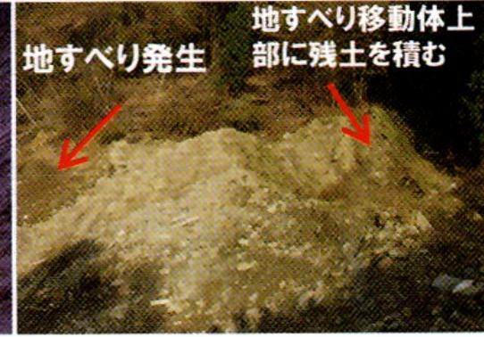
地すべり移動体上部 への盛土
