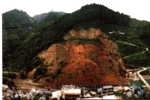
豪雨で生じた地すべり
