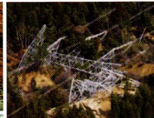
道路・送電線の建設
