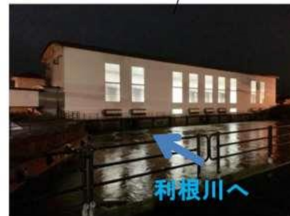
印旛機場から利根川への排水状況（10/13 1:00）
