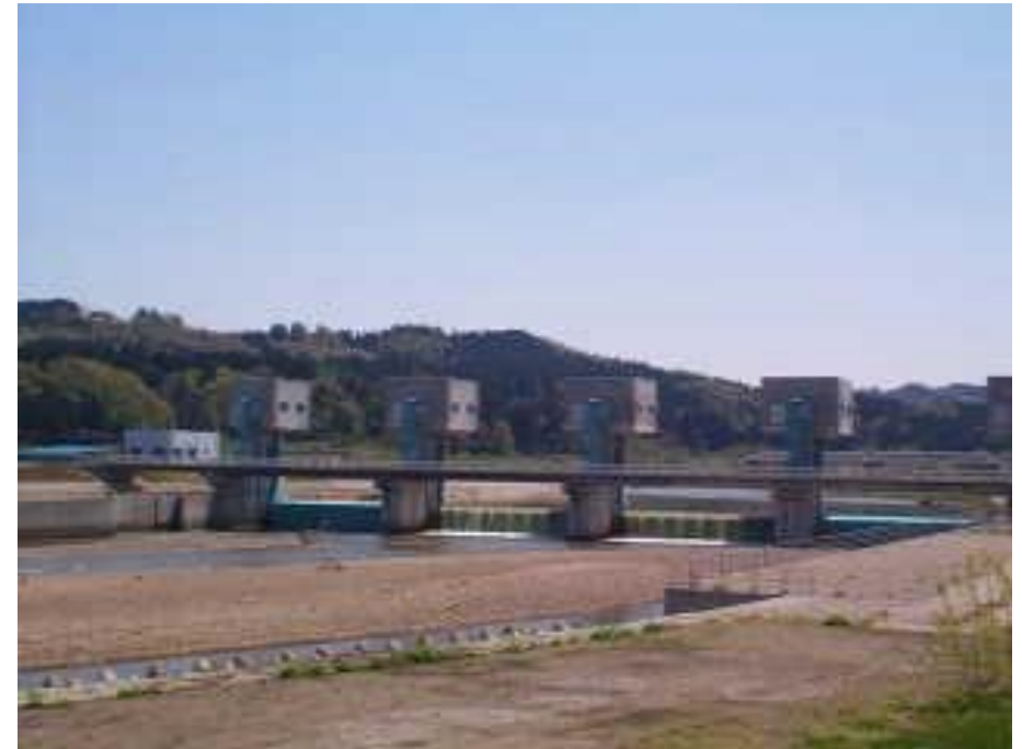
(信濃川左支川渋海川頭首工)
